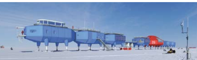
NFO Sinus® ska installeras på den nya brittiska klimatforskningsstationen Halley VI, som ska byggas av BAS på Sydpolen 2008.
